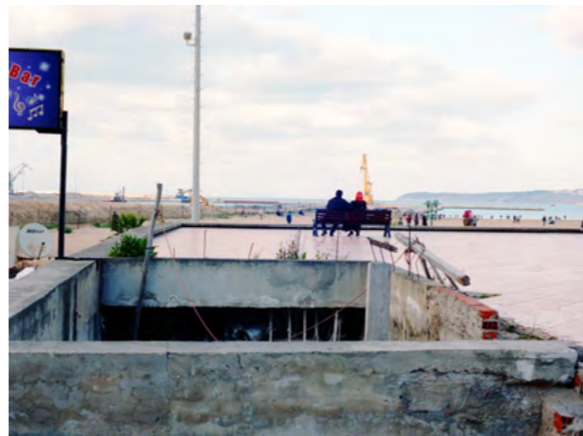
Bar en construction sur la Corniche
