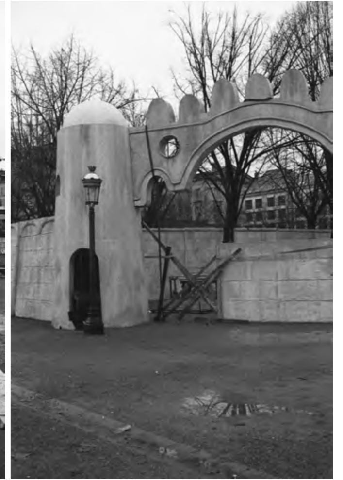
Château en cours de démontage
